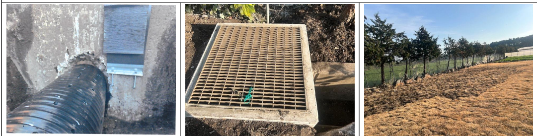
공사 후(좌로부터 유공관 설치, 맨홀 설치, 침투조 전경)
